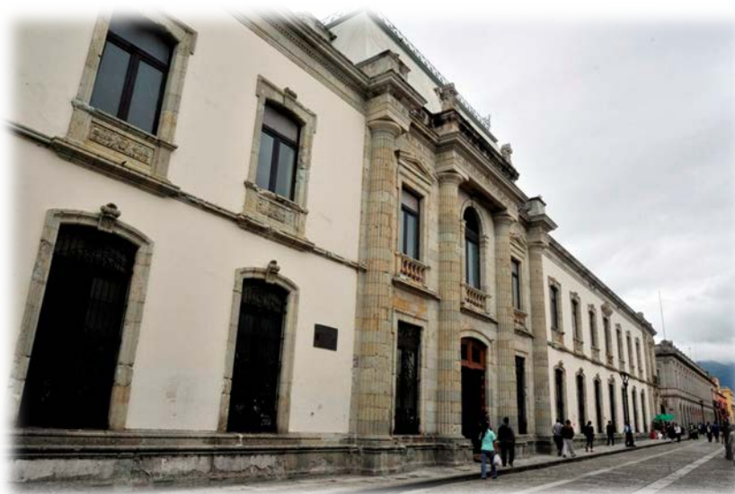
Fachada 19. Fachada lateral UAPJO
