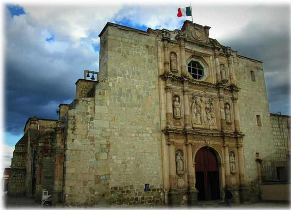
Fachada 17. Fachada principal ex convento de San Agustín
