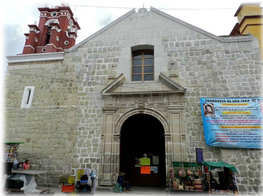
Fachada 13. Fachada lateral iglesia San Juan de Dios
