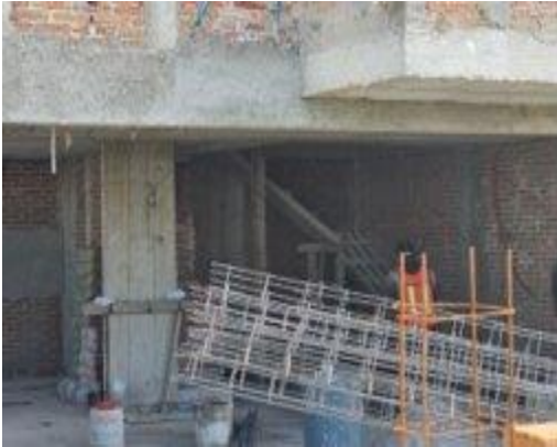
Fig. 1: Entrada principal de la obra de casa-habitación ubicada en Lomas de Angelópolis sección 3.
