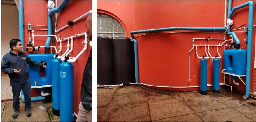
**Ilustración 53. Sistema de captación, filtración y desinfección de agua pluvial. Fotos: Pamela Núñez.**
