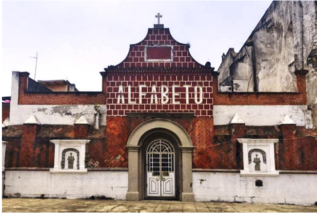
FIGURA 82. Salón Alfabeto, donde podría instalarse el Centro de Interpretación.
