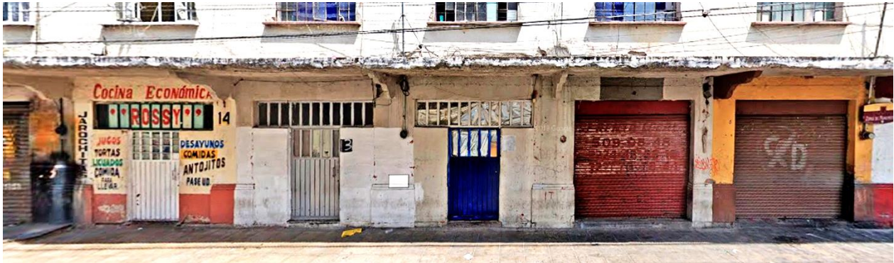
FIGURA 52. Locales comerciales desocupados en la Calle 3 Norte. Google Street View.
