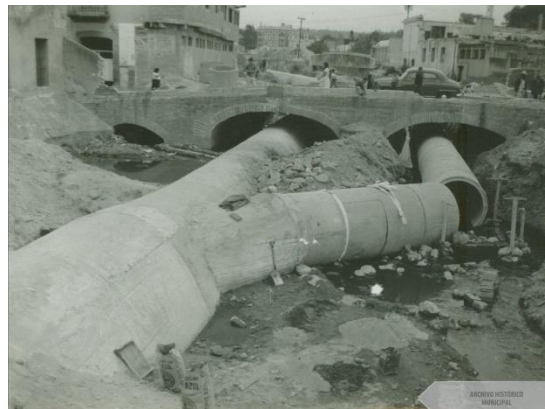
FIGURA 14. Obras de embovedamiento del Río San Francisco, concluidas en 1963. Archivo Histórico Municipal de Puebla.
