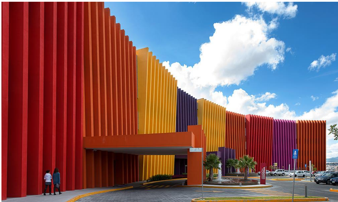
Imagen 14. Hospital Infantil de Oncología Teletón (HITO) en la ciudad de Querétaro, obra de Sordo Madaleno Arquitectos. (Navarro, J., 2013)
