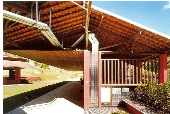
Imagen 14. Instalación de rociadores especiales de citronela, se distinguen los colores tierra empleados, así como los materiales. (Nelson Kon, 2005)
