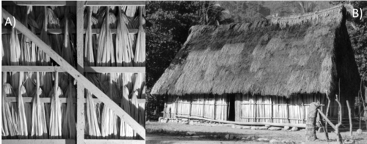
Imagen 17. A) Detalle techo de palma. (Cruz, M., 2017). B) Predominio de la estructura del techo a dos aguas de zacate en la arquitectura vernácula de Veracruz. (Yampolsky, M., 2017)
