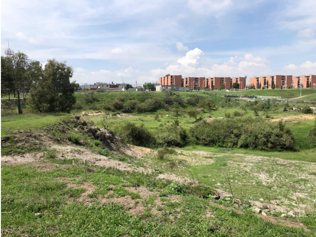
Imagen 8: Área socavón con colindancia de Infoanvit.
