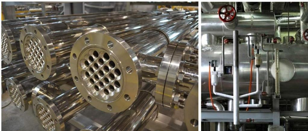
**Figura 8.** Aplicaciones de los aceros Ferríticos. De derecha a izquierda: intercambiadores de calor tubulares<sup>[18]</sup> y tuberías en acero inoxidable<sup>[19]</sup>
