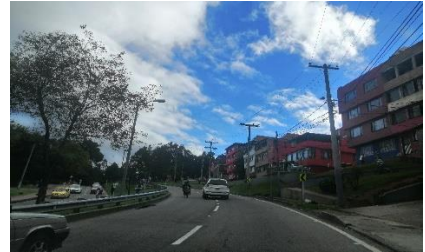
Barreras físicas y ausencia de cruces peatonales
