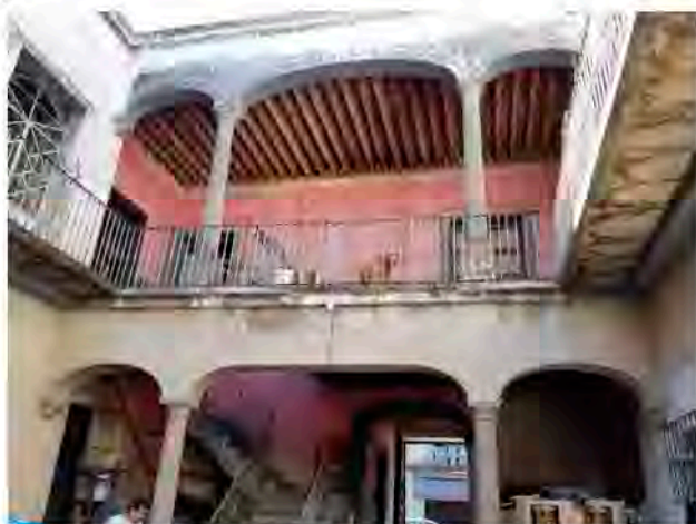
Imagen14. Vecindad abandonada. Foto propia.
