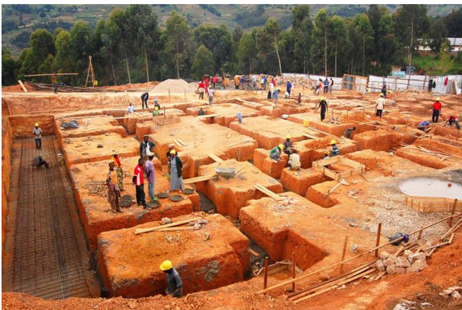
Ilustración x imagen del proceso de cimentación del hospital en Butaro. Fabricada con mano de obra local.
