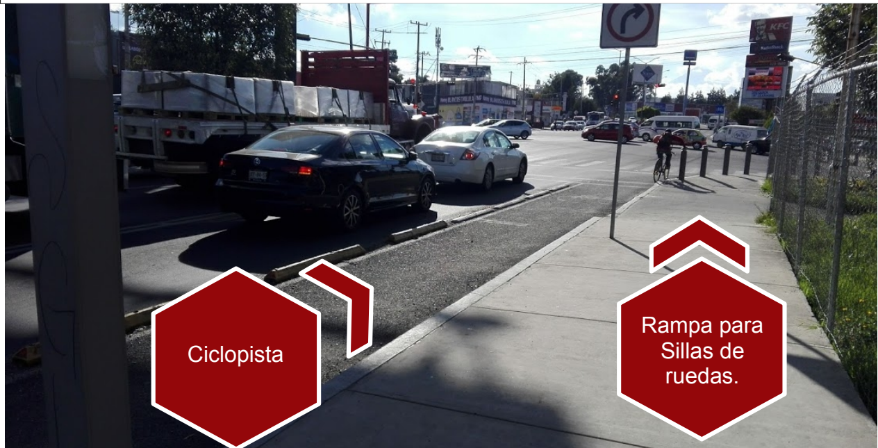
Imagen X: Esquina del Blvd. Forjadores con Calle 6 Norte. Fuente: Elaboración propia.
