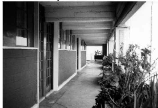
Fig. 2. Centro Urbano Presidente Alemán, ciudad de México. Vista actual de uno de los corredores que dan acceso a los apartamentos. (Foto: Acervo Lab. Audiovisual, Inst. Mora)
