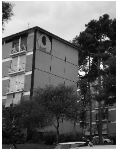
Fig. 2. Montbau: calle Poesía. Tabique pluvial con mural. Autor desconocido. Proyecto de rehabilitación del Arq. Josep Olivé Saperas. (Foto de la autora)
