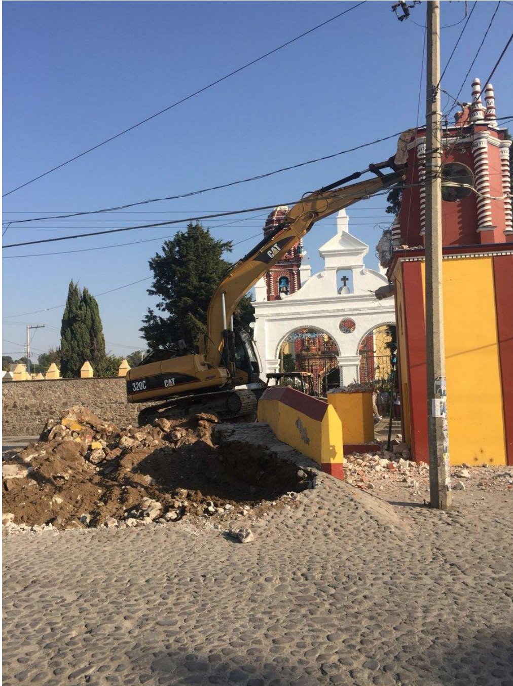
Ilustración 30 Destrucción del puente. Imagen redes sociales 11 de enero 2017 https://twitter.com/Victor51886687/status/951583105114099712
