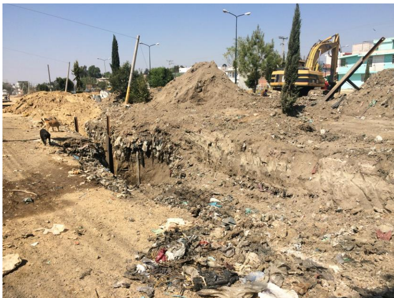
Ilustración 24. Excavaciones para obras de drenaje pluvial en la calle Brindissi, entre calle Salamanca y Londres. Fotografía tomada por la autora el 26 de marzo del año 2018.
