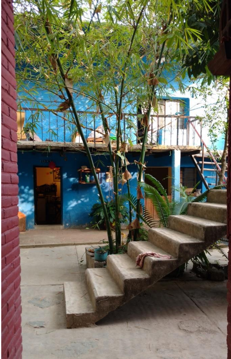
Foto 6. Escaleras vistas desde la sala de usos múltiples.
