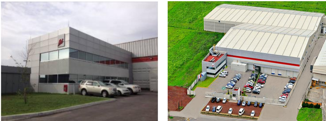
Figura 3.11. Edificio oficinas administrativas.
