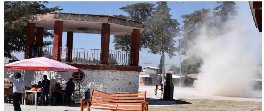
Imagen 1.3: Fotografía del estado actual de la cancha en Plaza Principal de San Miguel Espejo. Se visualiza una polvareda generada por los fuertes vientos en la zona la calidad de la materialidad del sitio. (Taller de Consolidación en Arquitectura, 2017)
