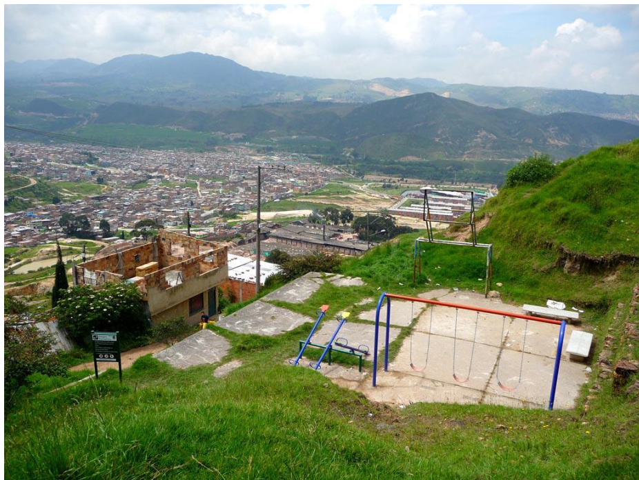
Imagen 7.7: Estado del Parque Alaska, previo a la intervención del Colectivo Arquitectura Expandida. (Arquitectura Expandida)
