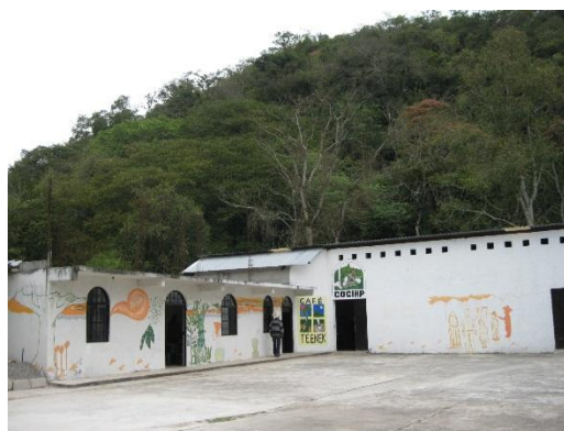
Instalaciones de la COCIPH Foto: Fundes, 2013
