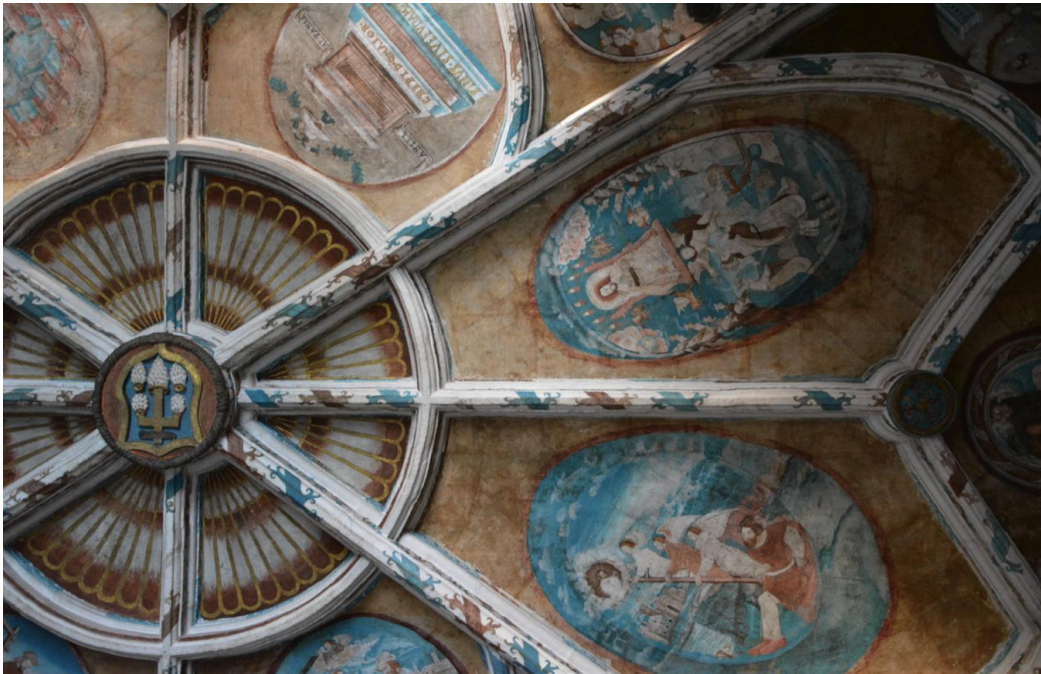
Figura 23. Bóveda de crucería Fuente: propia
