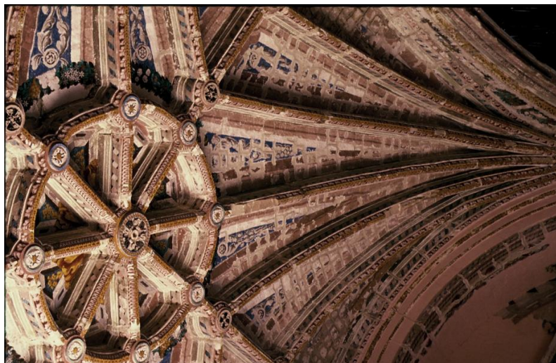
Fotografía 15. Imagen de las nervaduras del convento San Juan Bautista Coixtlahuaca, Oaxaca.
