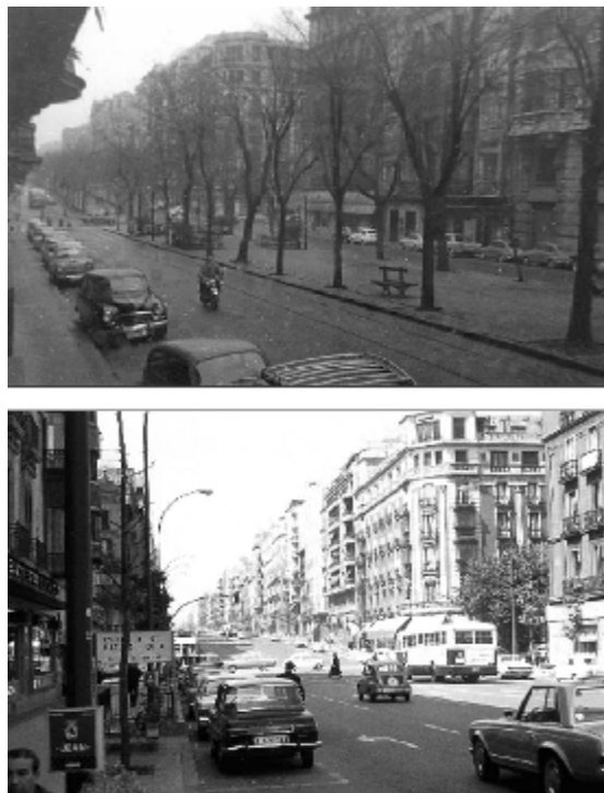
Fig. 7. Madrid. Transformación de la calle Velázquez: antes (arriba) y después (abajo). (Fotos del autor).
