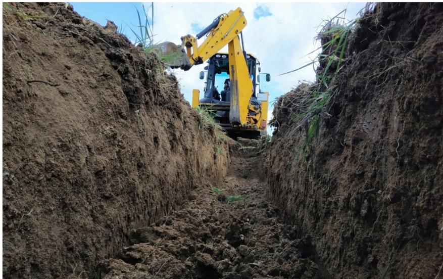
Imagen 4: excavación de pozo a cielo abierto.
