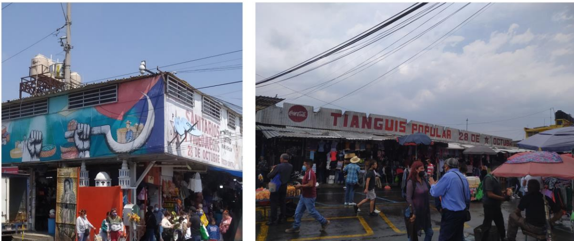
Figura 3.9 Frente del Mercado Hidalgo sobre el Bulevar Norte
