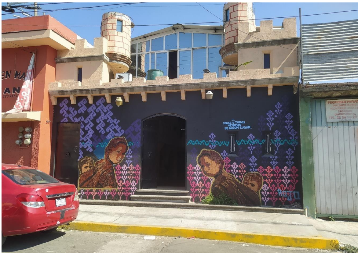
Figura 4.1 Instalaciones de la escuelita de Yo'on ixim (febrero, 2023)
