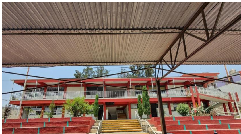
Figura 3. Edificio 2 Tse. Lic Salvador Zamudio
