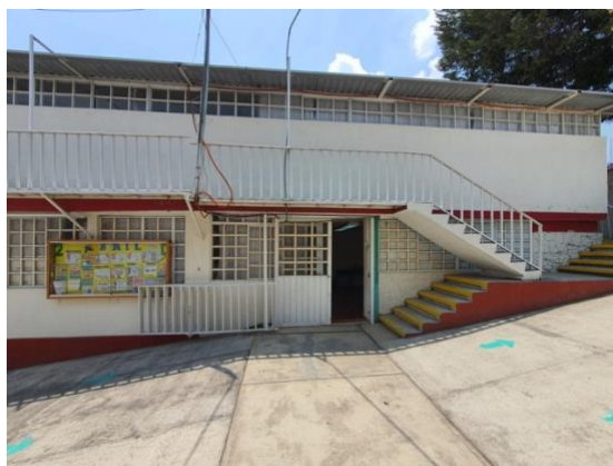
Figura 4. Edificio 3 Tse. Lic. Salvador Zamudio
