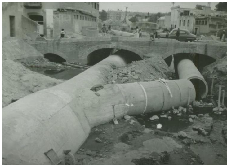
Ilustración 10. Proceso de entubamiento del río San Francisco. Fuente: Archivo histórico de Puebla.
