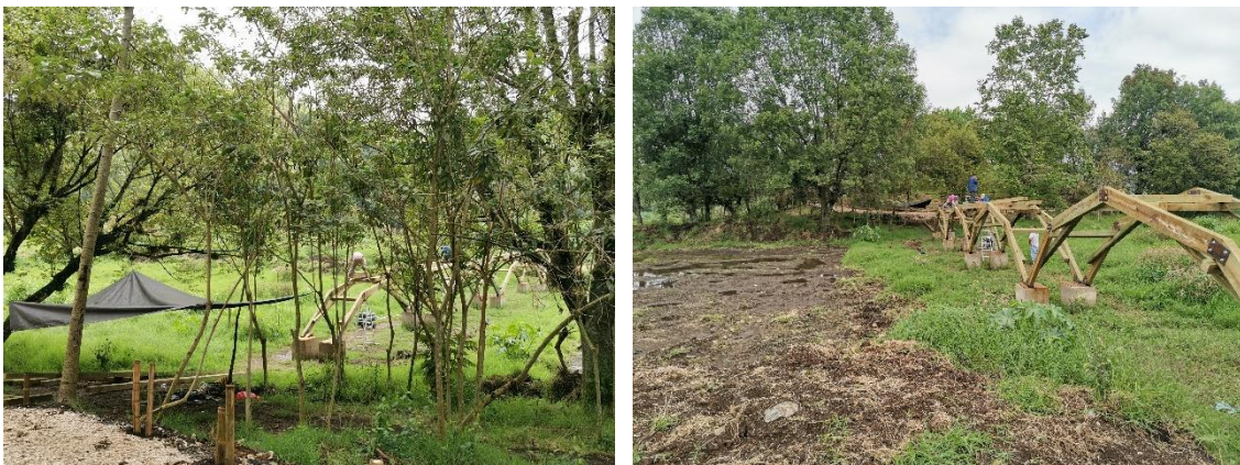
Ilustración 54. Proceso de obra de la restauración del pantano. Fotos: Pamela Núñez.
