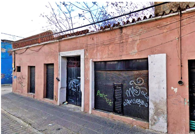
FIGURA 60. Fachada de 3 Norte 2201, La Casa del Capitán Fantasma. Google Street View.
