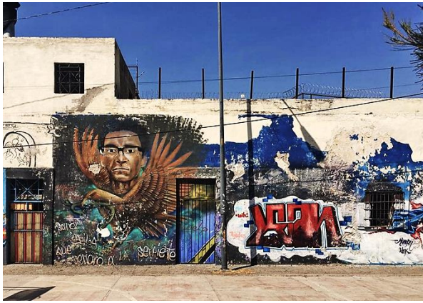
FIGURA 88. En este edificio de la plaza, podría instalarse el Mercadillo de Comida.
