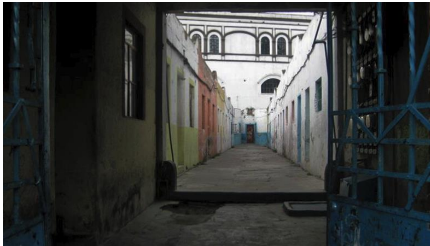
FIGURA 56. 5 de Mayo 2405, una de las últimas vecindades que aún existen en San Antonio. En este modelo, las viviendas se distribuyen a los costados de un pasillo.
