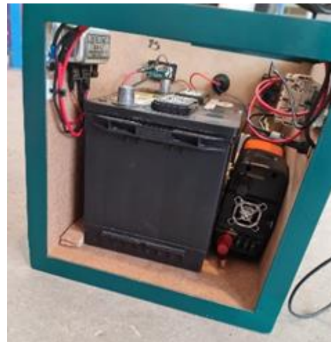
Fig. 11. Interior de la estación de carga
