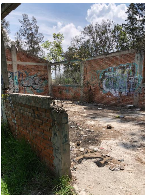
Imagen 9: Construcción abandonada dentro del predio.
