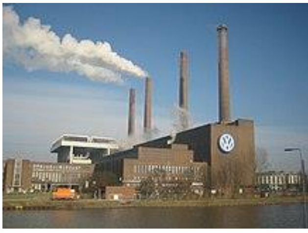
Imagen 4: Se observa Planta principal en Wolfsburg.
