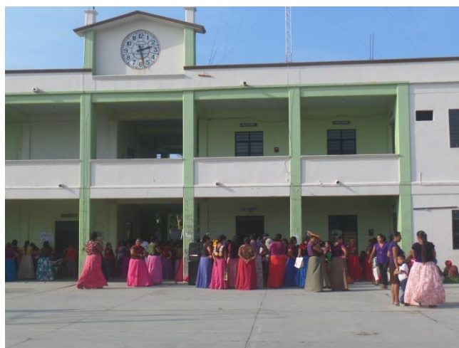
Fotografía 2. Palacio municipal de San Mateo del Mar, Oaxaca
