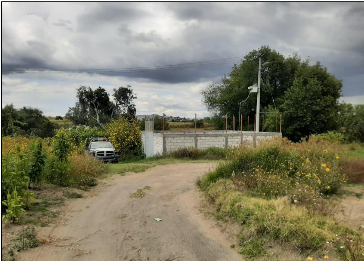
Pozo de extracción de agua subterránea en San Jerónimo Tecuanipan. Parcela de Juan.
