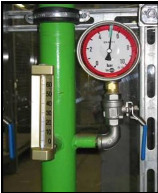
Ilustración 43, indicador visual de correcto parámetro de presión. Fuente, Elaboración propia del alumno.
