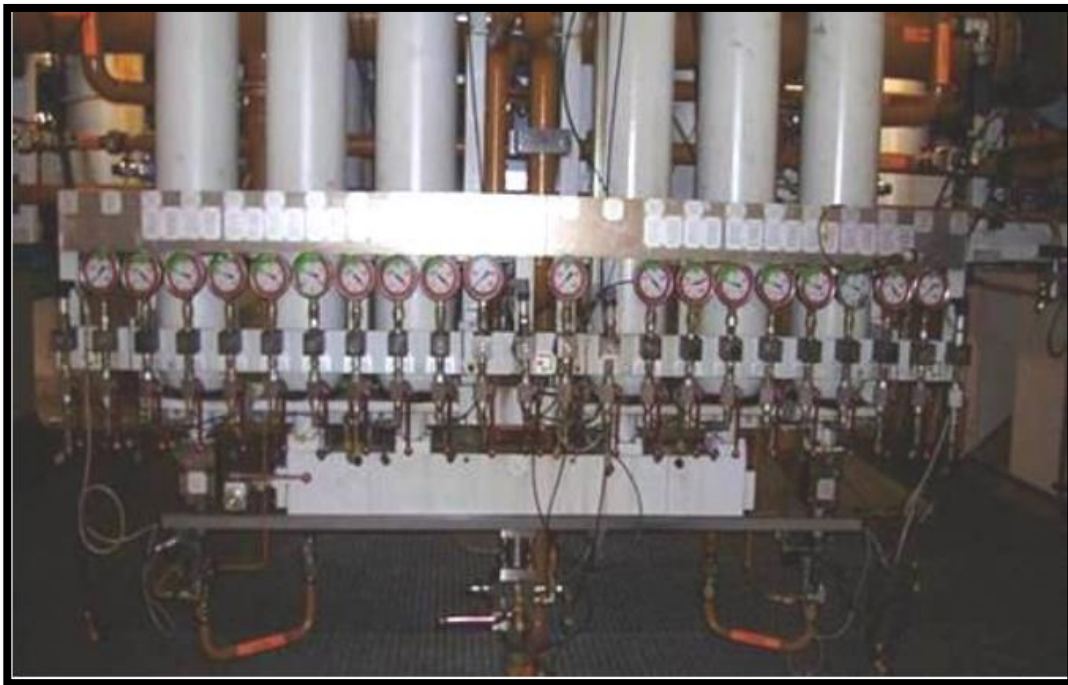
Ilustración 40, Implementación de mejora en medidores de presión para la reducción de recorridos. Fuente, elaboración propia del alumno.
