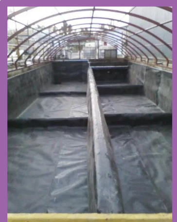
Figura 2: Arpimix. (2021). Fosa de Retención de Ácidos Recubierta con GMB HDPE . Recuperado de: https://arpimix.com/hellomotoiden-5/
