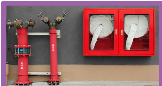
Figura 44: La Unión S.L. (s.f.). Sistemas de extinción. Columna seca e hidrantes. Recuperado de https://extintoreslaunion.com/columna-seca-e-hidrantes
