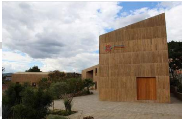
Fotografía. Fachada principal Centro Cultural Teotitlán del Valle. Fuente: Gerardo Corres Zenteno
