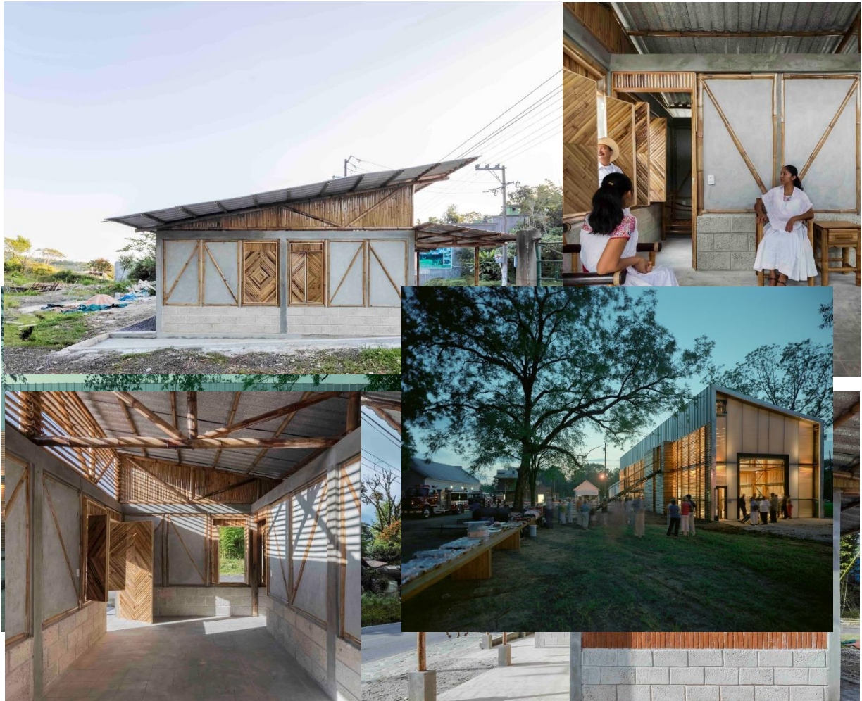
Ilustración x imágenes de la vivienda de Comunal Taller de Arquitectura ilustrando la mezcla de materiales vernáculos con materiales aprobados por la CONAVI obtenido de: https://www.archdaily.mx/mx/868727/vivienda-en-puebla-comunal-taller-de-arquitectura?ad_medium=gallery
