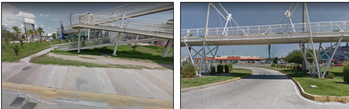
Imagen 46 y 47. Materiales y pavimentos
