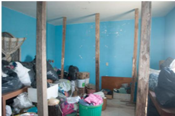
Apuntalamientos dentro de una casa para sostener el derrumbe de la planta alta.
