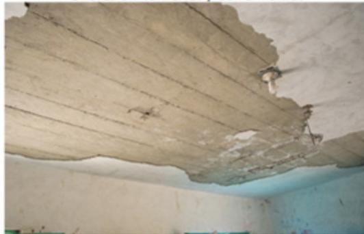
Desprendimiento de revoque en losa armada.
