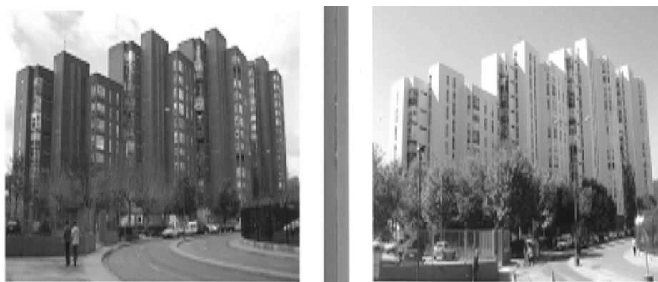
Fig. 3. Vistas del polígono “Río Vena” (Burgos) antes y después del ARI. (Fuente: Áreas de rehabilitación . Folleto publicado por la Junta de Castilla y León)
