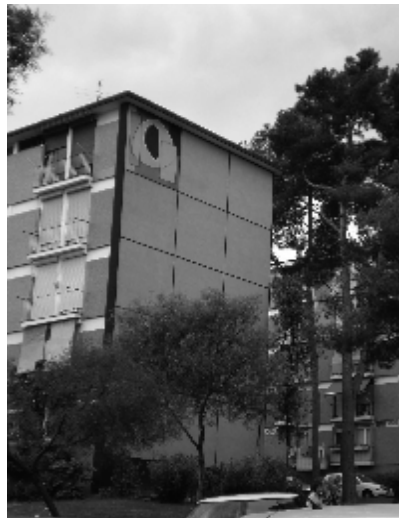
Fig. 2. Montbau: calle Poesía. Tabique pluvial con mural. Autor desconocido. Proyecto de rehabilitación del Arq. Josep Olivé Saperas. (Foto de la autora)
