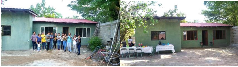
Imagen 20: Primera vivienda terminada
