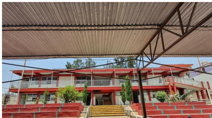
Figura 3. Edificio 2 Tse. Lic Salvador Zamudio
