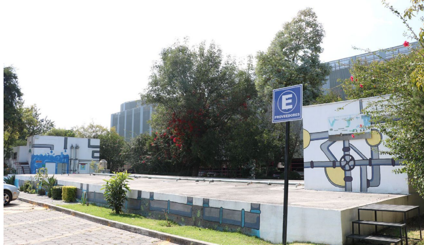
Figura 17. Planta de tratamiento de aguas residuales de la IBERO Puebla.
