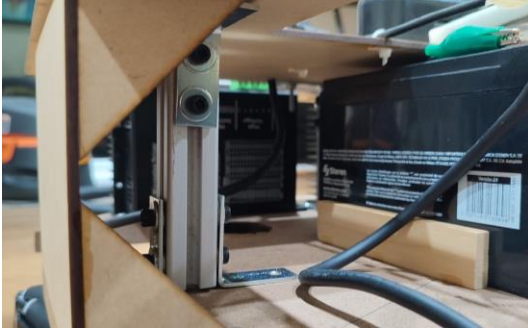
Fig. 8. Soportes estructura interna.
