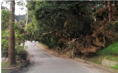
Vías sin aceras peatonales ni iluminación
