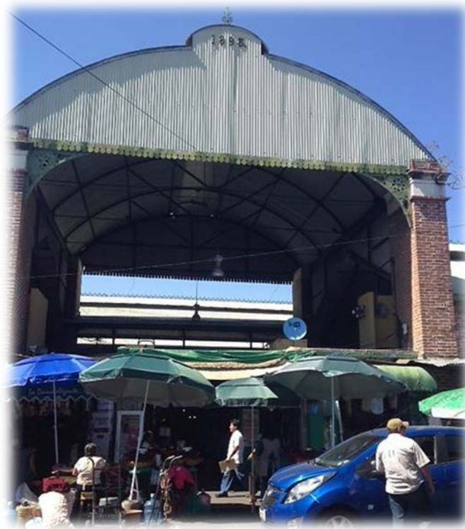
Fachada 20. Fachada principal mercado Benito Juárez
