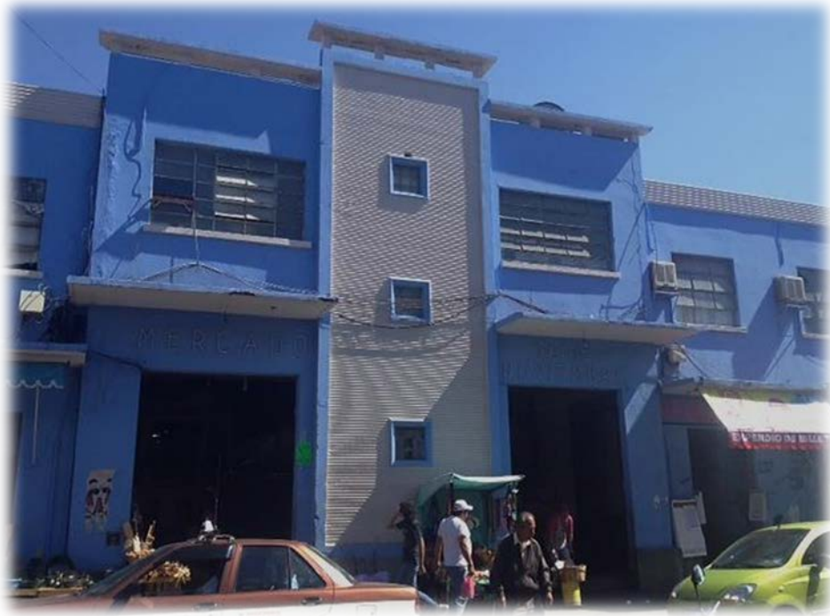
Fachada 21. Fachada principal mercado 20 de Noviembre
