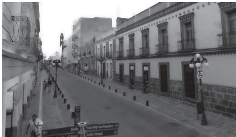
Foto 1. Calle Juan de Palafox y Mendoza: Ampliación de las banquetas dando preferencia al paso peatonal reduciendo el arroyo vehicular. Foto de Yazmín Rasgado Gallegos.
