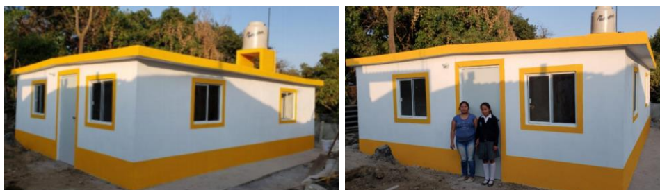
Imagen 25: Fachada principal del Prototipo de vivienda ASUA Anáhuac
