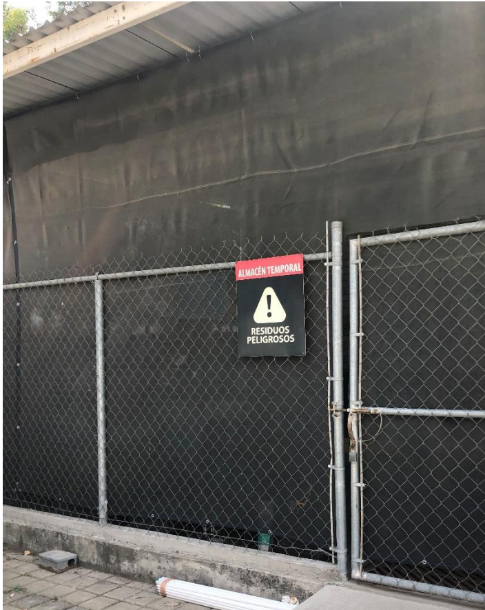
Ilustración 11 Almacén temporal RP de un lado de IDIT
