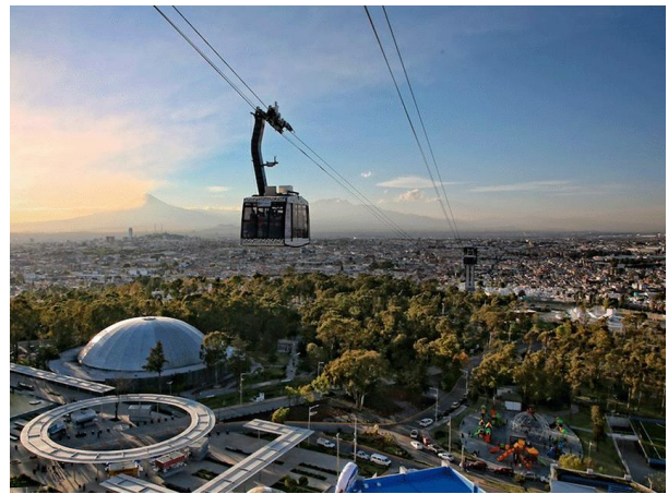
FIGURA 21. Teleférico de Los Fuertes. Gobierno del Estado de Puebla.
