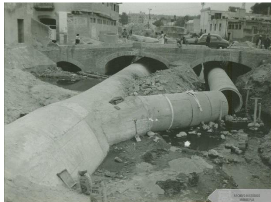
FIGURA 14. Obras de embovedamiento del Río San Francisco, concluidas en 1963. Archivo Histórico Municipal de Puebla.
